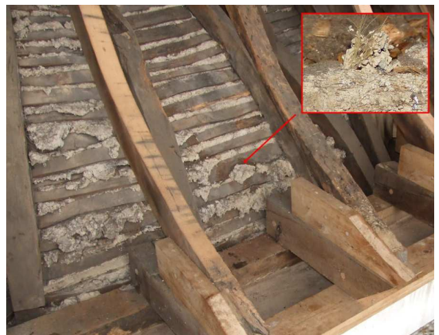
Abb. 4 Ripphölzer mit Stakung und Putz, rot Tierhaare im Putz
