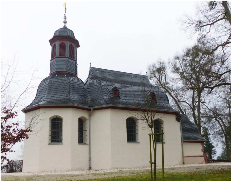
Abb. 1 Ansicht 2016 von Nord-Ost
