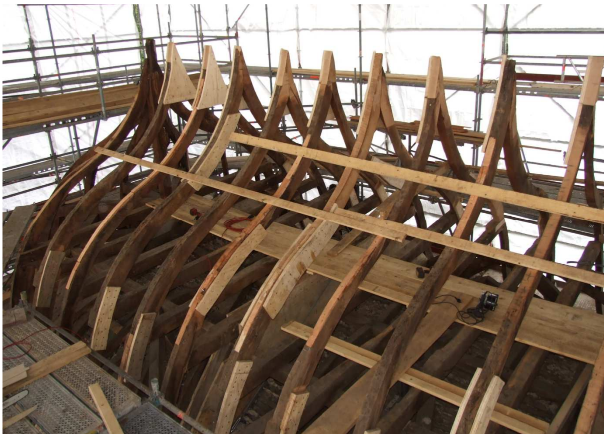
Abb. 8 Additiv restauriertes Dachtragwerk unter maximalem Erhalt der Originalsubstanz
