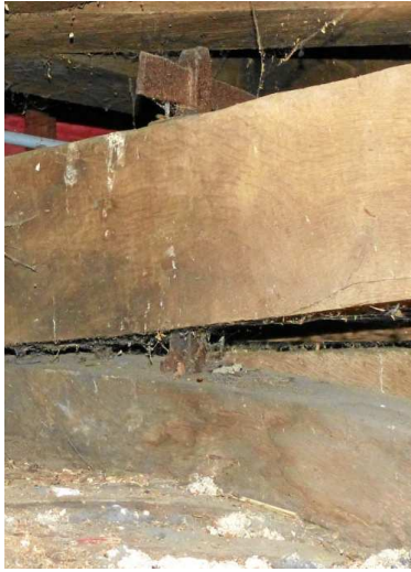
Abb. 5 Aufhängung Ge- wölberippe über Dem Chor
