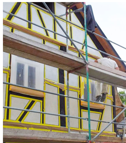
Abb. 14 Gefache Freskalanstrich Heißkalktünche
