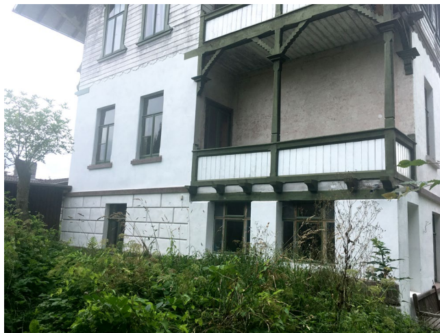
Abb. 17 + 18 Neuer Glattputz und Reparatur der Quarderung mit NHL-Kalkmörtel an einer Fassade in Bad Sooden-Allendorf; Fertigzustand (rechts)
