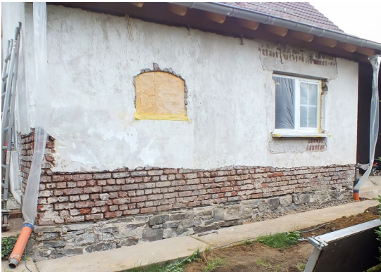
Abb. 10-12 Fassadeninstandsetzung eines Stallgebäudes mit Kalkputz – freskal mit Heißkalkanstrich (Oberflächendetail rechts)
