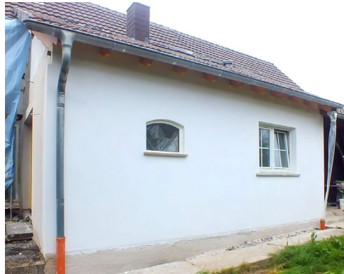
Abb. 10-12 Fassadeninstandsetzung eines Stallgebäudes mit Kalkputz – freskal mit Heißkalkanstrich (Oberflächendetail rechts)
