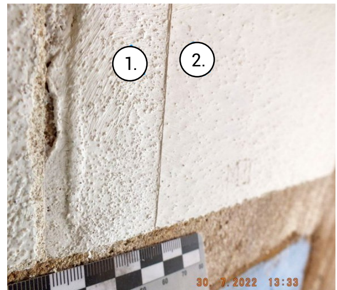
Abb. 5 Monitoring Zinhain, 1. und 2. Heißkalkanstrich
