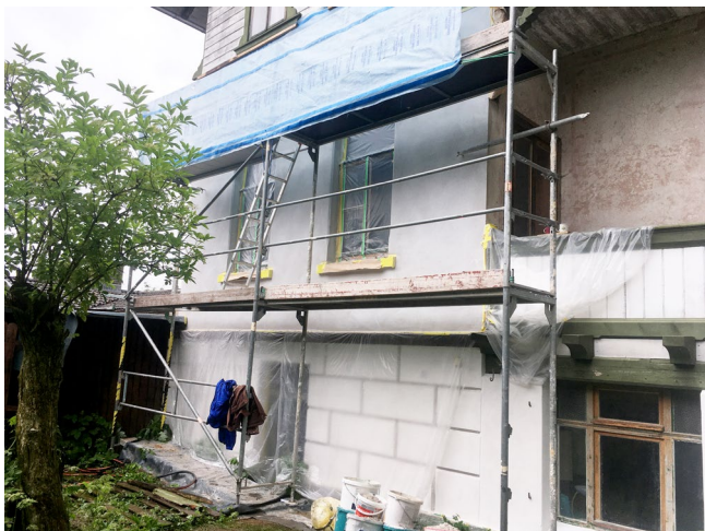
Abb. 17 + 18 Neuer Glattputz und Reparatur der Quarderung mit NHL-Kalkmörtel an einer Fassade in Bad Sooden-Allendorf; Fertigzustand (rechts)
