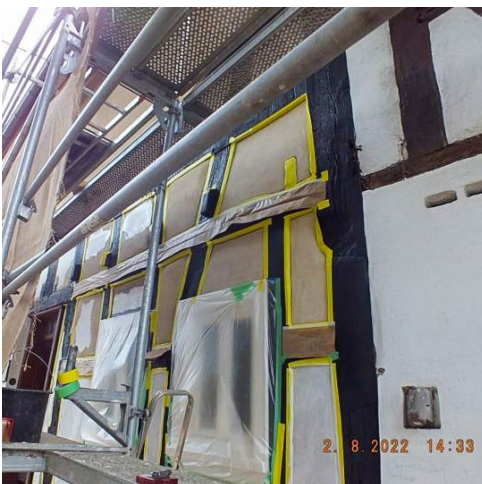
Abb. 13 Verputzte und teils freskal gestrichene Gefache
