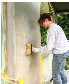
Abb. 19 Erster Freskalanstrich in Heißkalktünche
