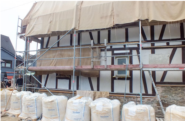
Abb. 8+9 Gefache mit Kalkputz und Heißkalkanstrich, freskal ausgeführt
