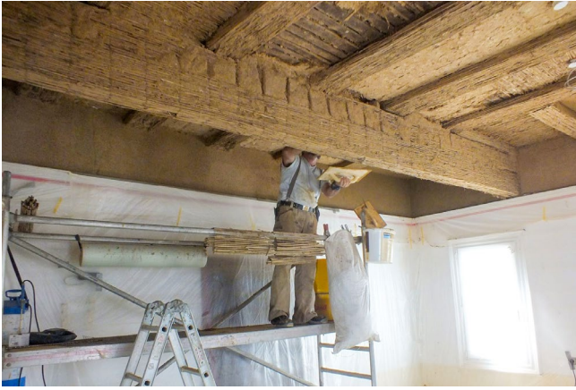
Abb. 6+7 Instandsetzung einer Decke: Strohlehm, Kalkputz, freskaler Heißkalkanstrich
